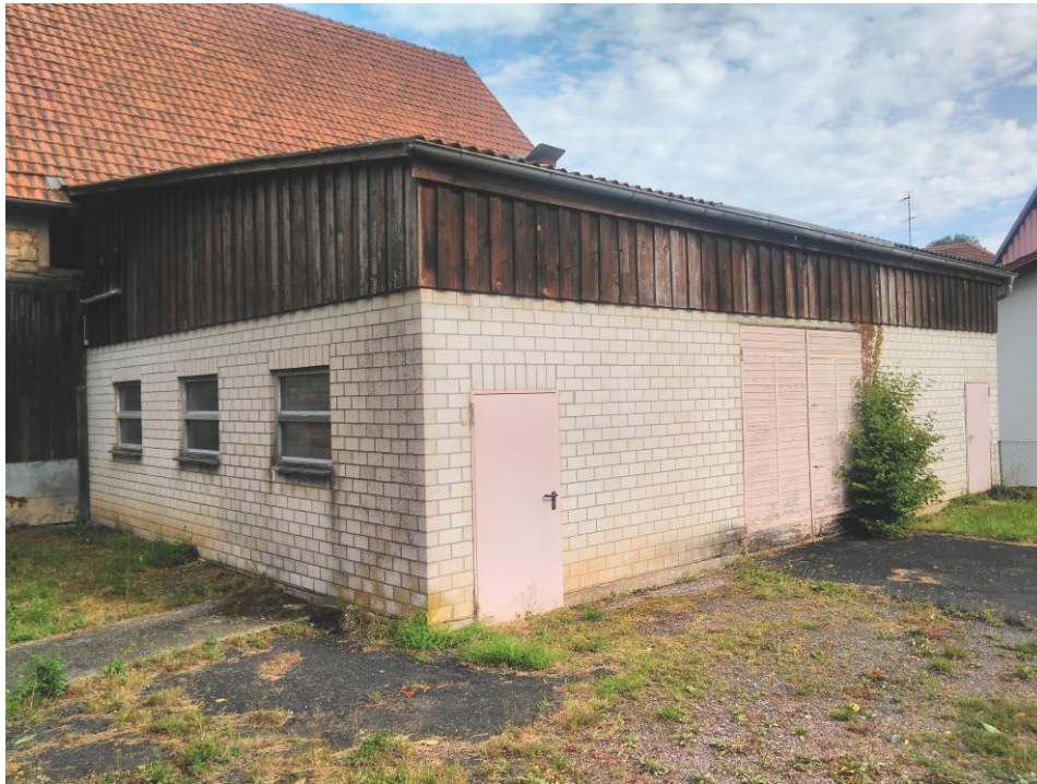
Foto 1.: Blick auf Gebäude Nr. 1. (vgl. Abbildungsverzeichnis ): Ehemaliger Kuhstall (zur Zeit Lagerraum) im Anbau aus Kalksandstein mit Holzvertäfelungen der oberen Fassadenbereiche und Schrägdach aus Asbest-Wellplatten: Hier sind Habitatstrukturen für (Spalten-) Fledermäuse vor allem im DG vorhanden, so dass ein manueller Rückbau des Daches (u.a. ohnehin nach TRGS 519) und eine gutachterliche Nachkontrolle vor dem Abbruch erfolgen muss.
