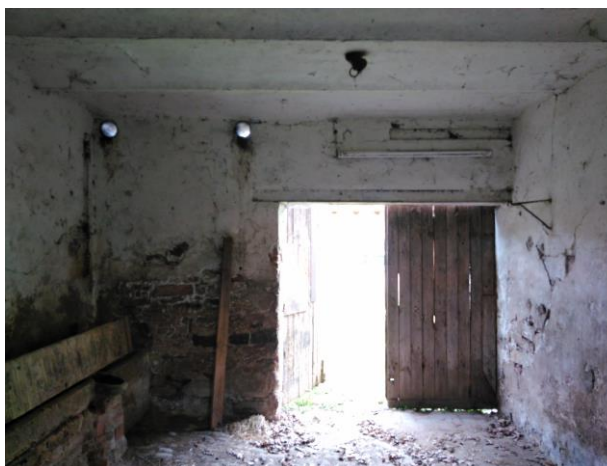
Foto 13.: An einem Haken an der Decke von Gebäude Nr. 3 . (EG) hatte eine Rauchschwalbe einst ein Nest errichtet, als der Hof noch in Betrieb war. Mit der Aufgabe der Tierhaltung an diesem Ort, wurde die Kolonie vermutlich zeitnah aufgegeben.
