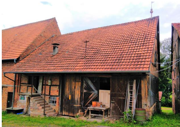
Foto 12.: Die Nordostseite von Gebäude Nr. 4 zeigt, dass die Gebäude dieses Hofes durch die offene Bauweise zahlreiche potenzielle Fledermaus-Einflüge ins Gebäude-Innere und Fledermaus-Quartiere aufweisen.
