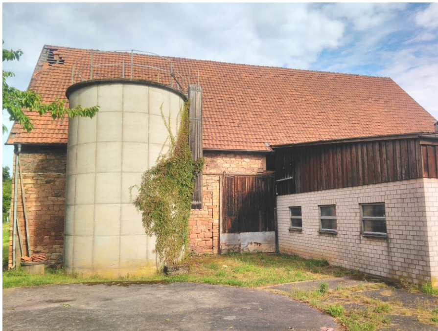
Foto 2.: Unterirdischer Güllebehälter ( Nr. 10. , l.u., o.B.), Betonsilo ( Nr. 9. , mitte links, o. Befund), Gebäude Nr. 1. (rechts im Bild) und Gebäude Nr. 2. , Große Scheune mit Sandsteinmauer(!) mit ehemaligem Kuhstall im EG (verlassene Rauchschnalben-Nester, verwitterter alter Fledermaus -Kot einer
