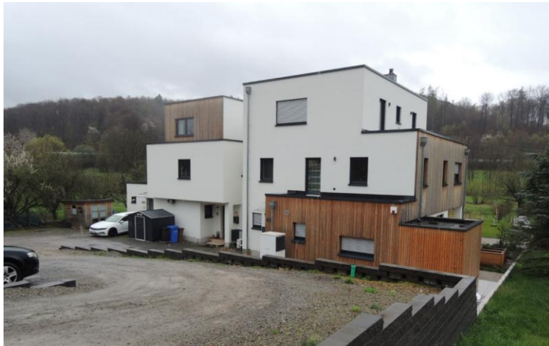
Zurückspringende Bebauung in der Aschaffener Straße mit Parkflächen davor
