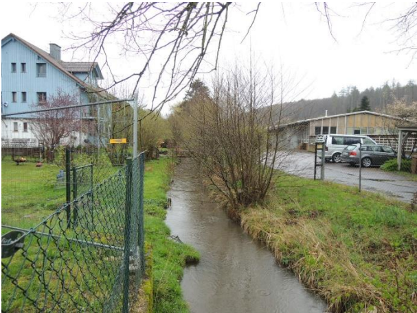
Der Uferbereich des Laufachbaches im Bereich der Brücke
