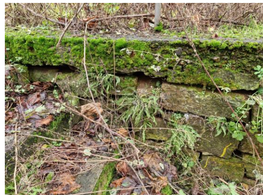
Foto Nr. 41. und Foto Nr. 42.: Im Außenbereich gibt es mehrere Sandsteinmauern mit Spalten , in denen sich Fledermäuse oder bodennah auch Feuersalamander verkriechen können, die ganzjährig(!) vor einem Abbruch, einer Sanierung oder Reinigung auf eine Besiedlung durch Fledermäuse zu kontrollieren sind ( Ausleuchten , ggf. Videoskopie , manueller Rückbau , wenn Besiedlung nicht ausgeschlossen werden kann). Mit Zauneidechsen ist aufgrund der feucht-kühlen Bedingungen hier eher nicht (mehr) zu rechnen.
