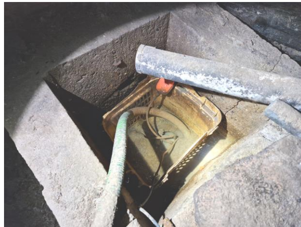
Foto Nr. 29.: Pumpensumpf mit anstehendem Grundwasser. Die Pumpe ist außer Betrieb. Die Rohrverbindungen zum Abwasserrohr sind alt und marode. Es besteht möglicherweise die Gefahr, dass Abwasser ins Grundwasser eindringen könnte!
