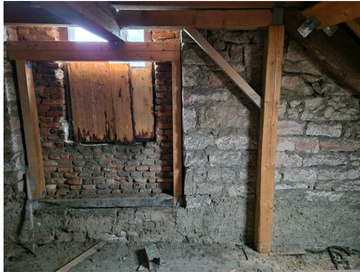
Foto Nr. 38.: Unter anderem am westlichen Giebel des Brauhauses (sowie einer Zwischenwand im DG) sind Spalten und offene Mauerfugen vorhanden, die Spalten-Fledermäuse ein Quartier bieten können. Einflugöffnungen sind im DG vorhanden. Vor einer Sanierung, einem Abbruch, etc. oder auch dem Verschließen der Einflüge sind diese Strukturen einer gutachterlichen Nachkontrolle durch Ausleuchten und ggf. Videoskopie zu unterziehen.
