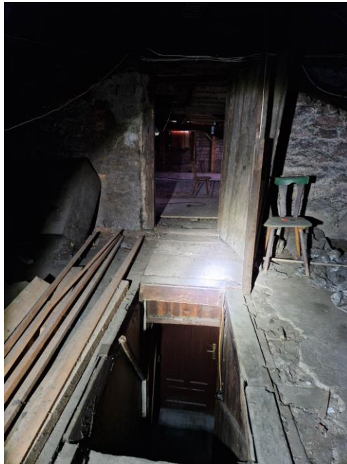
Foto Nr. 36.: Das Treppenhaus ins DG ist offen und ermöglicht Mardern und Fledermäusen gleichermaßen den Eintritt ins Innere des Gebäudes.
