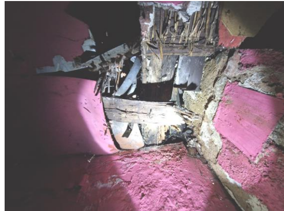
Foto Nr. 33. und Foto Nr. 34.: Blick auf die Kegelbahn im 1. OG des Nebengebäudes und einen Wasserschaden mit Einbruch der Decke, der Fledermäusen einen Einflug vom Dachgeschoss (DG) ins OG und damit das gesamte Gebäude insgesamt ermöglicht. Hier kann auch der Marder das Gebäude betreten (siehe Marderkot im Gebäude).
