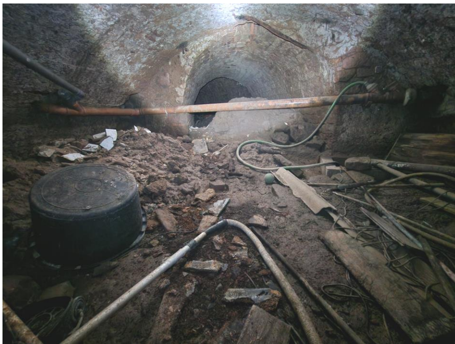
Foto Nr. 28.: Blick aus der ersten in das zweite Sandstein-Kellergewölbe (hinter dem waagerechten Abwasserrohr): Es gibt zwei ineinander übergehende Röhren, die leicht versetzt zueinander liegen. Am Versatzabschnitt hinter dem Abwasserrohr gibt es einen großen Haufen Erdreich (viele Kubikmeter!) , der von oben eingeflossen ist. Die Standsicherheit des Geländes darüber könnte gefährdet sein! Der grüne Schlauch führte Wasser vom Pumpensumpf mit anstehendem Grundwasser (Siehe Foto Nr. 29.) direkt in ein altes Abwasserrohr. Die Pumpe ist außer Betrieb. Die Rohrverbindungen sind alt und marode. Es besteht möglicherweise die Gefahr, dass Abwasser ins Grundwasser eindringen könnte!
